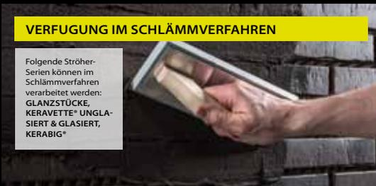
Im Schlämmverfahren werden die Fugen mit dem Fug- oder Putzbrett diagonal verfüllt. Wandflächen sind von oben nach unten zu verarbeiten.
