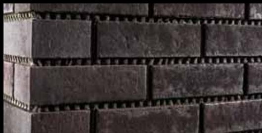
Die fertig verlegte Fläche. Nach Standzeit kann mit dem Ausfugen begonnen werden.
