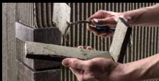
Die Eckwinkel werden im Floating-Buttering-Verfahren verarbeitet.
