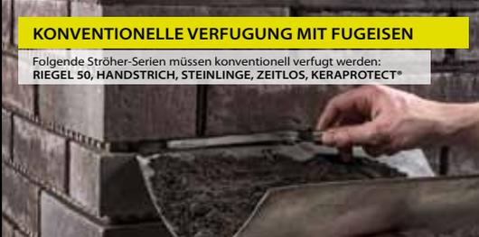
Die Verfugung mittels Fugeisen und Fugblech in der Horizontalen.
